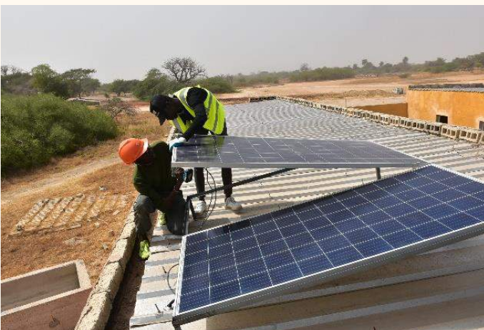
Installation des panneaux solaires
